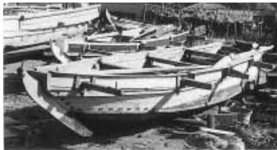
ボウチョウブネ (舫船) 全長 6 m 34cm 肩幅 1 m 18cm
